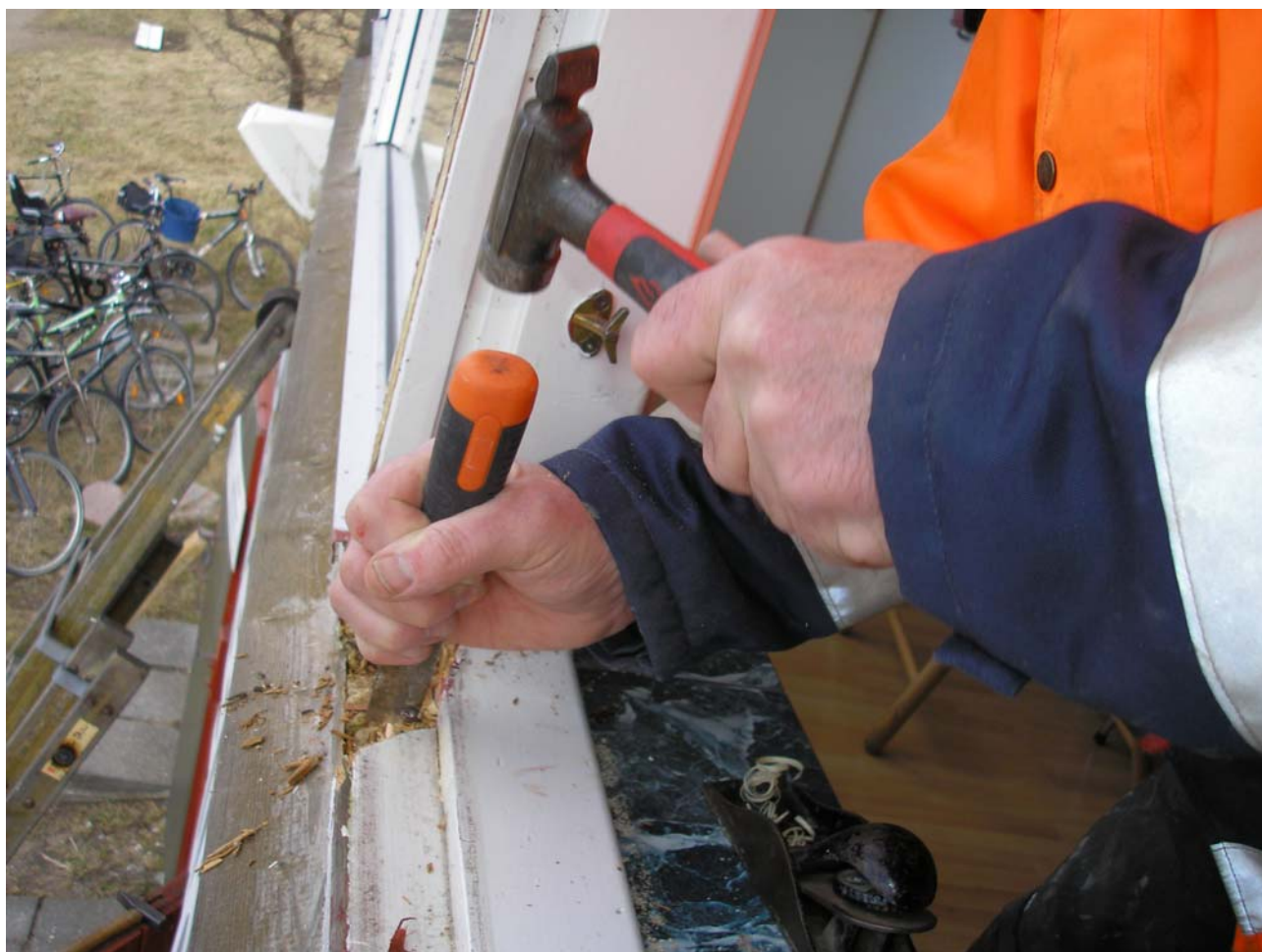
Reparationsarbejde på huset i år
